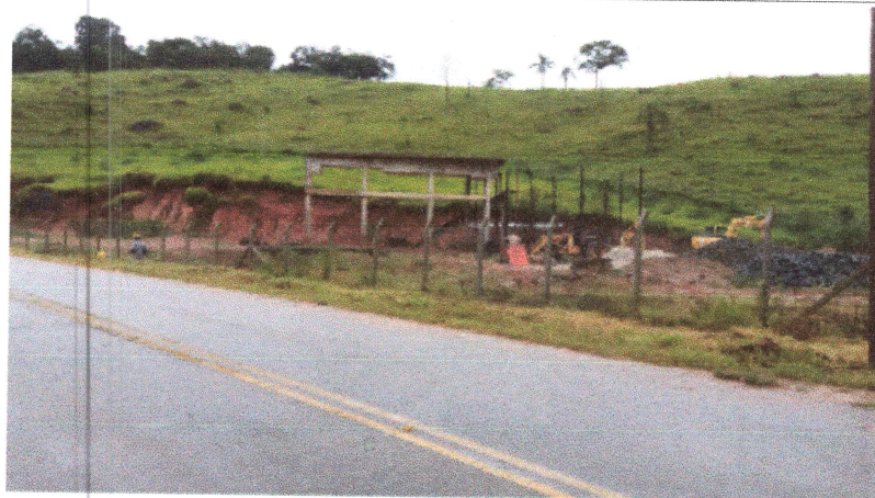
Foto 02: Estação de Tratamento de Esgoto - Vista e Terraplenagem.
