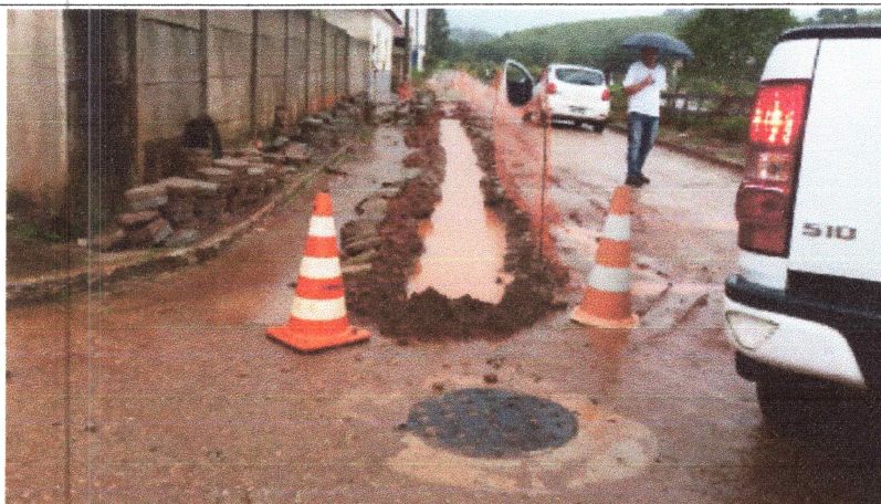
Foto 07: Interceptor - Trecho em execução em via urbana.
