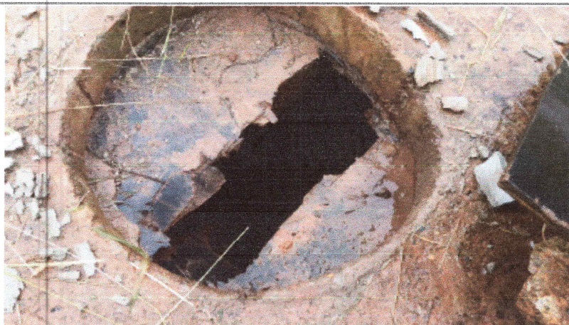
Foto 19: Detalhe da caixa de passagem executada da travessia.
