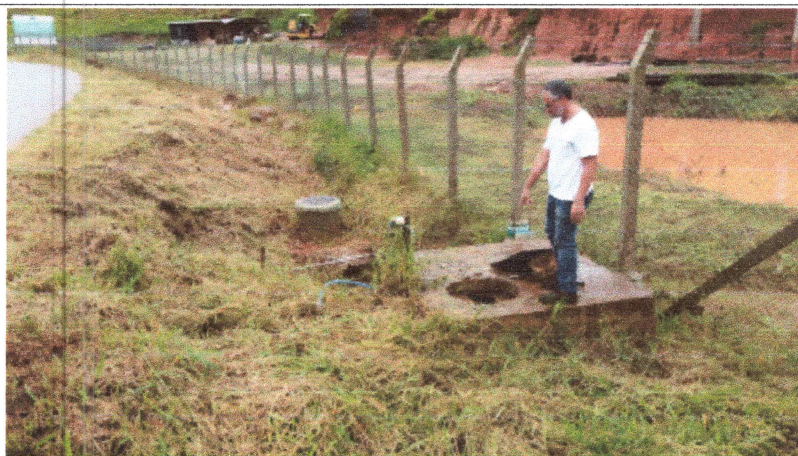
Foto 18: Local na área da ETE onde será implantada a EEE Final.
