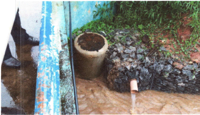
Foto 10: Interceptor - Trecho executado e contenção executada em Gabião.
