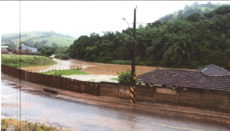
Foto 16: Interceptor - Trecho executado.
