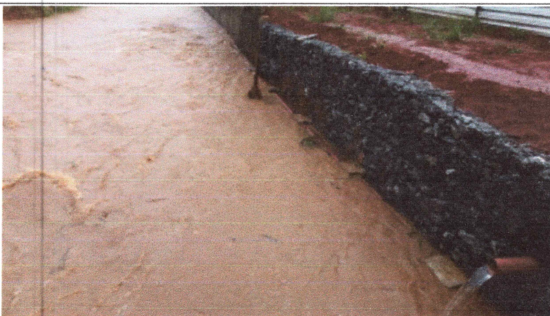
Foto 08: Interceptor - Trecho executado em FoFo e contenção em Gabião.
