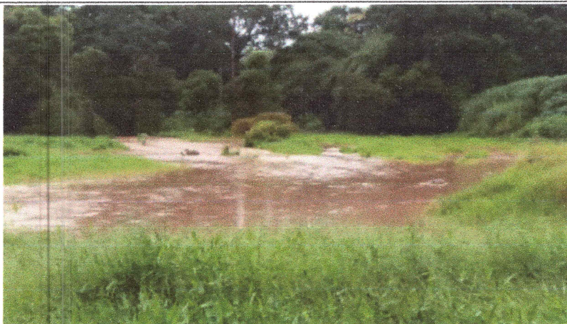
Foto 15: Interceptor - Trecho executado.
