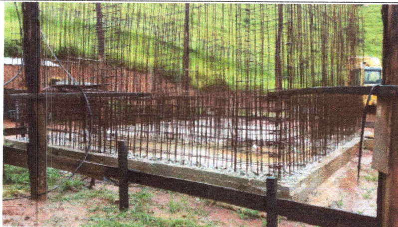
Foto 05: Estação de Tratamento de Esgoto - Execução de UASB.
