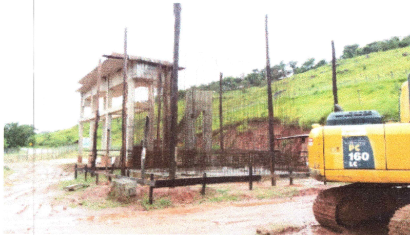
Foto 03: Estação de Tratamento de Esgoto - Execução de estruturas.
