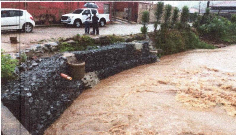
Foto 12: Interceptor - Trecho executado e contenção executada em Gabião.
