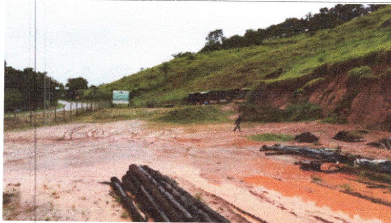
Foto 01: Placa e Canteiro de Obras.
