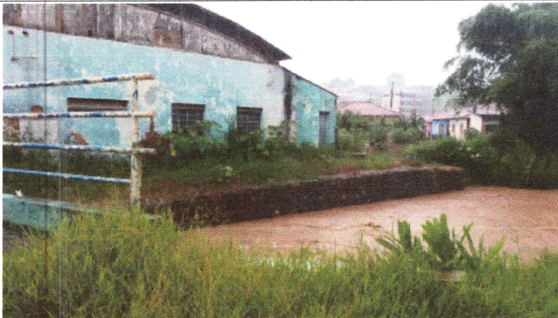
Foto 11: Interceptor - Trecho executado e contenção executada em Gabião.
