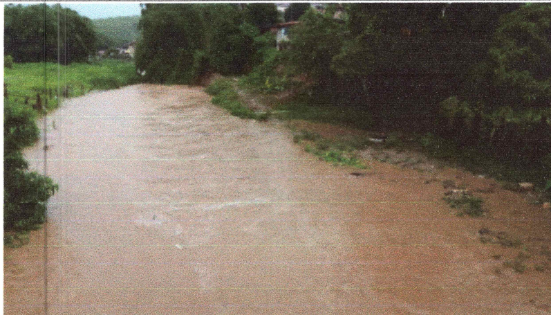
Foto 14: Interceptor - Trecho executado.
