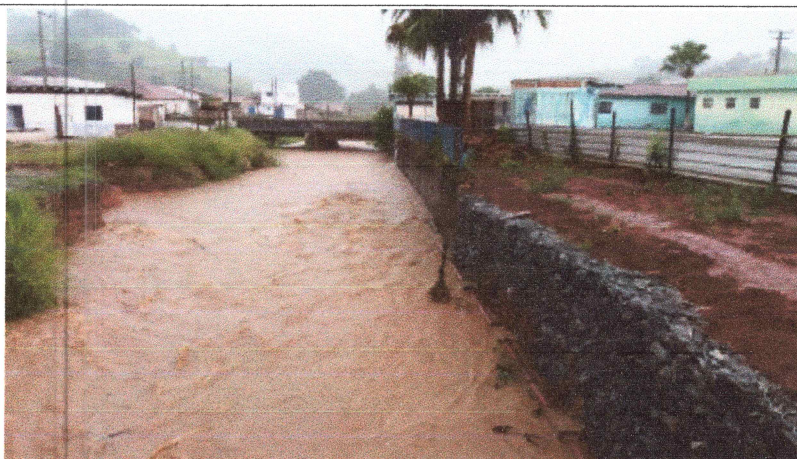
Foto 09: Interceptor - Trecho executado em FoFo e contenção em Gabião.
